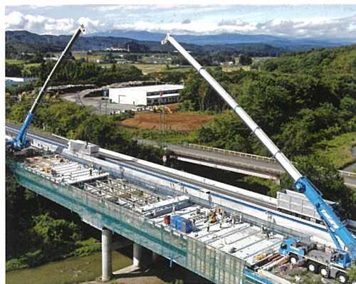
工事実施状況
