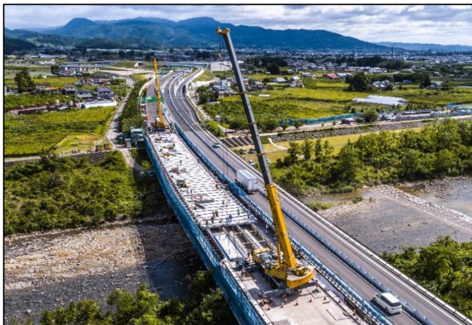
【対面通行規制状況】
