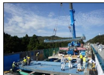
【新しい床版設置状況】
